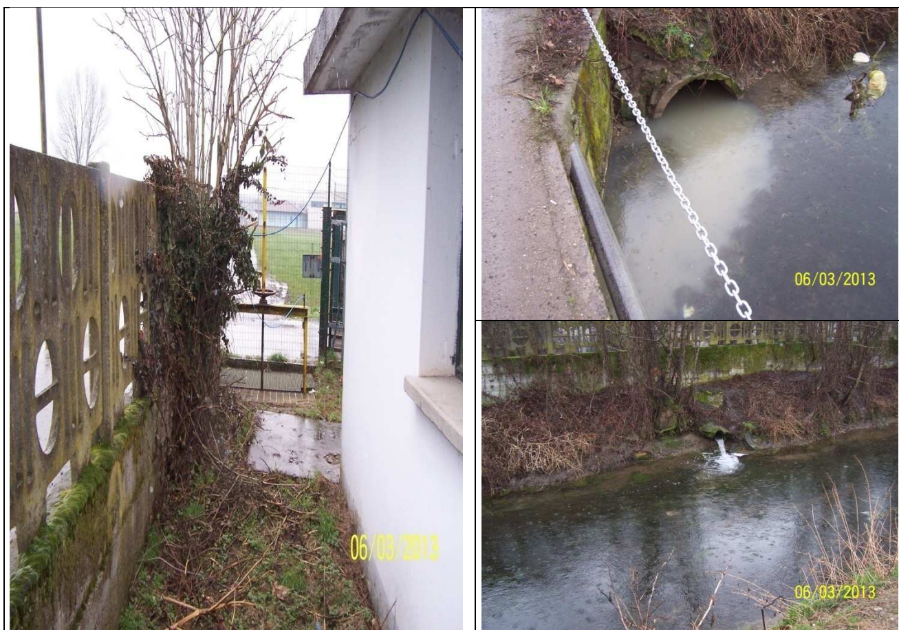
Foto 1, 2 e 3 – Pozzetto derivazione e sfioro, collettore di scolmatura DN 1.000, collettore scarico acque depurate DN 200
