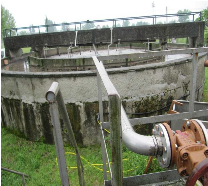
Foto 2-3: Bacino di ossidazione a pianta circolare esistente
