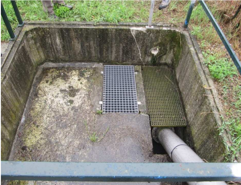
Foto 2-2: Filtrocclea esistente
