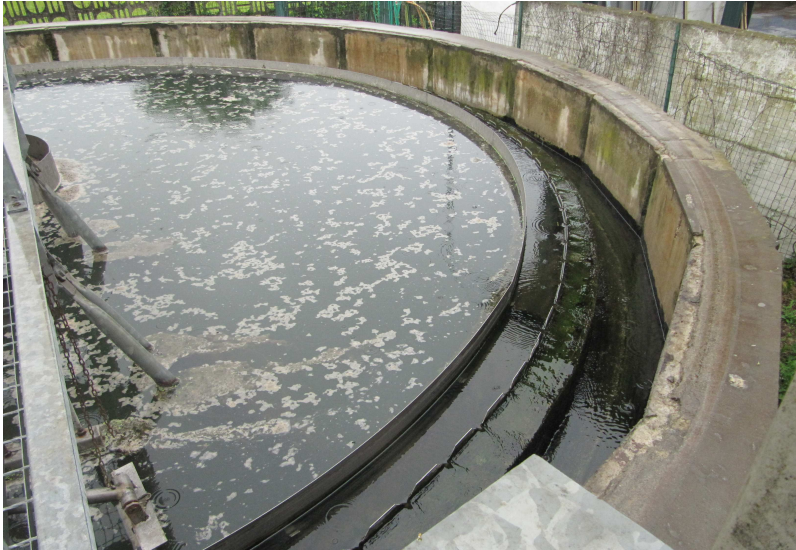
Foto 2-4: Particolare vasca di sedimentazione finale esistente
